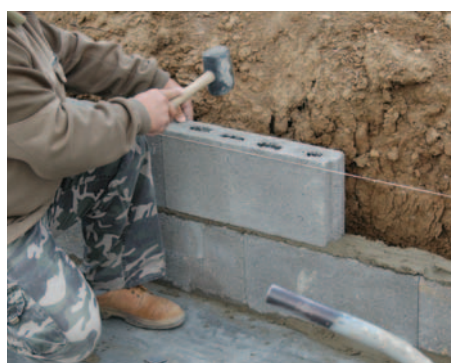
4. Válaszfalelem beállítása
