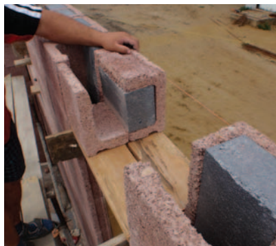
21. A nyílásáthidalás építése
