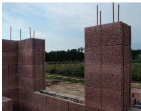
9. Falvégek függőleges erősítővasalása
