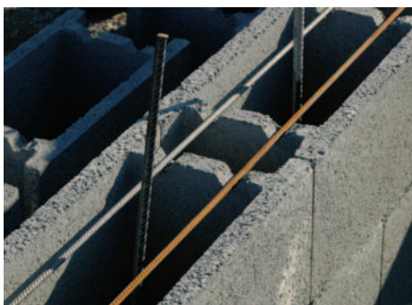
7. Függőleges és vízszintes vasalás betonzás előtt
