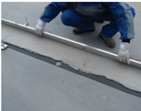
8. Kezdősor alatti habarcssáv kialakítása
