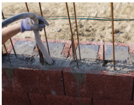
16. Bedolgozott beton tömörítése
