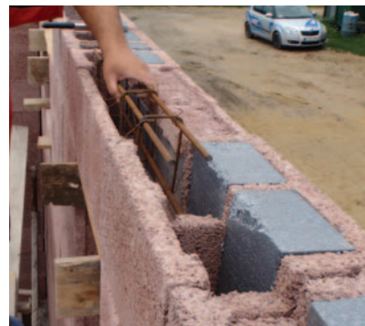
22. Vasalás behelyezése a nyílásáthidalásba
