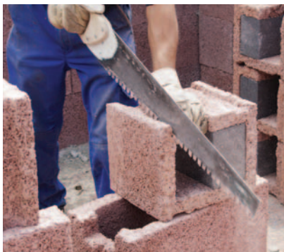
20. A nyílásáthidalásba építendő elem bordáinak kivágása
