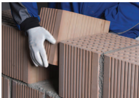
37. Vágott elem elhelyezése hanggátló falba
