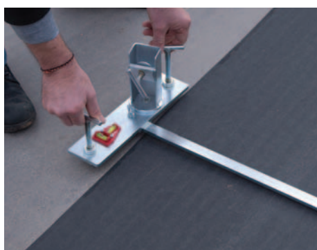
6. Szint beállítása a nivelláló készleten
