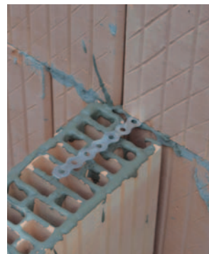
22. Válaszfalelemre hajtott bekötőszalag
