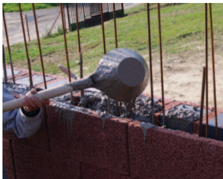
15. Kézi betonbedolgozás
