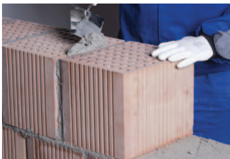
36. Hanggátló fal függőleges habarcshezag
