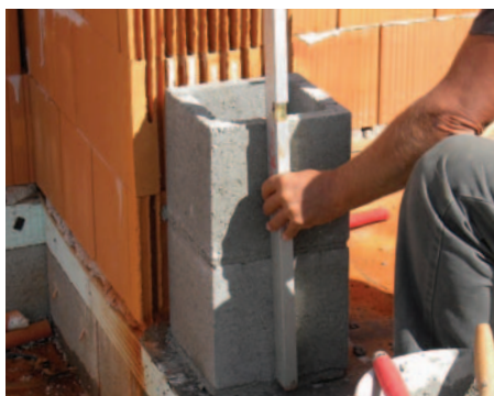
10. A függőleges ellenőrzése
