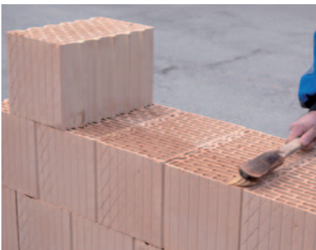
13. LeierPLAN falazóelem előnedvesítése ragasztás előtt
