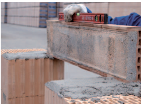
43. Felfekvésí felület LeierPLAN falszerkezet esetén
