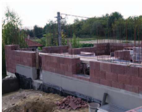
14. Szakaszosan betonzott falszerkezet építése
