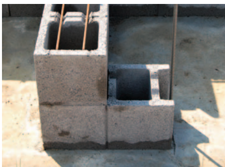
5. Falsarok kialakítása
