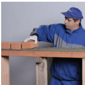
50. Nyomott öv falazása
