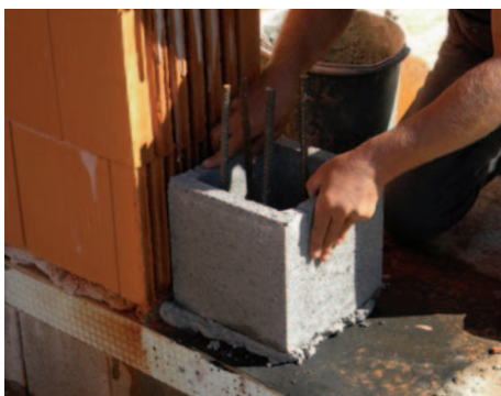
9. Első pillérzsaluzó elem elhelyezése
