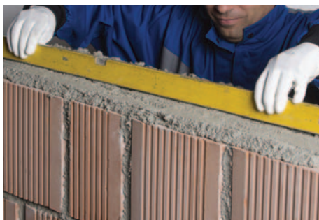
38. Hanggátló fal építése: falegyen képzés
