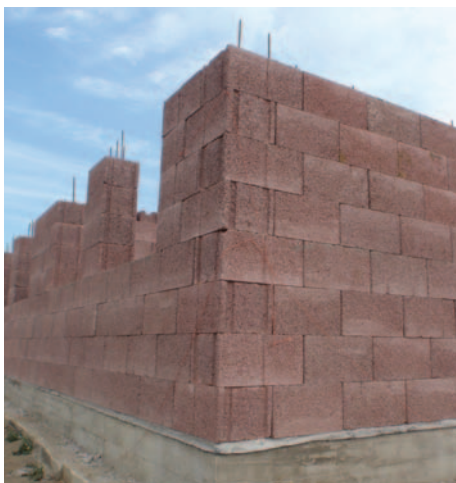
1. Vasbeton lábazatra épített Durisol falszerkezet
